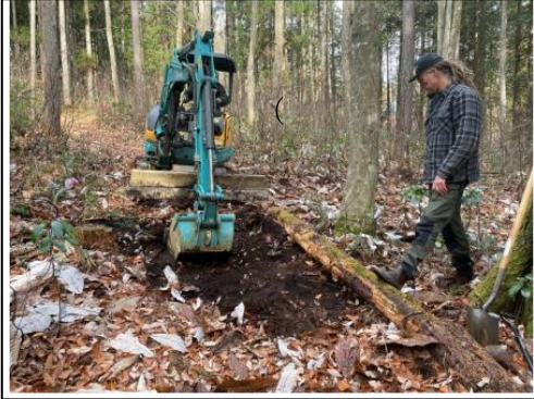
【重機による作業】
