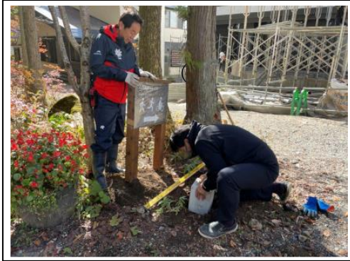
【看板設置作業】
