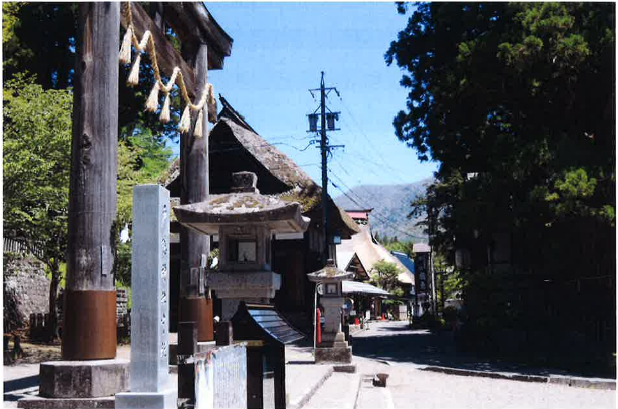
長野市戸隠伝統的建造物群保存地区 (H29.2.23 宿坊群では全国で初めて重伝建に選定)
