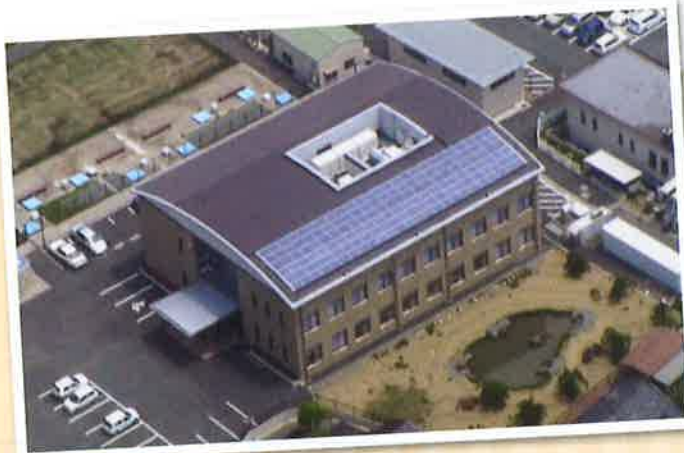
北信発電管理事務所（北信制御所/企業局川中島庁舎）
