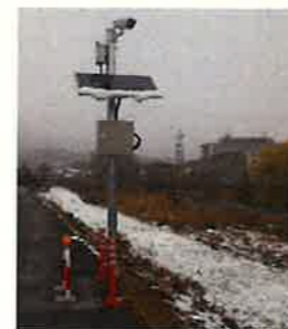
簡易型 河川監視カメラ
