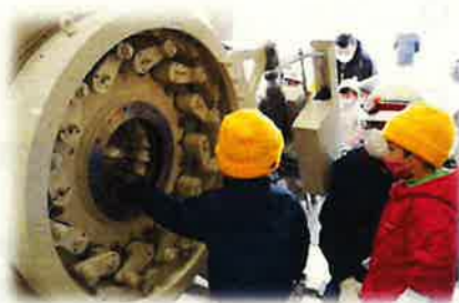
【工事現場見学会の様子】
