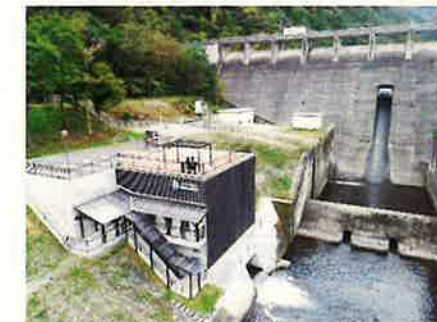
「横川蛇石発電所」 (R2年10月竣工)は、地域の学びの場や観光資源としても活用され、災害時等の停電時には、地域へ電力供給ができる非常用コンセントを有する。
