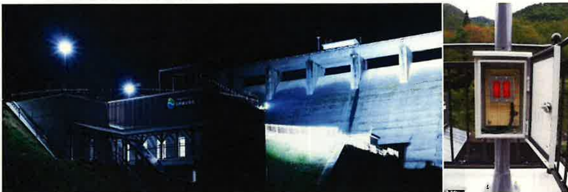
ライトアップ中の発電所
