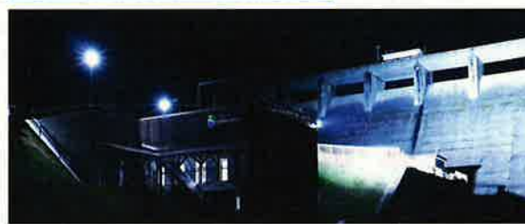
ライトアップ中の発電所(左)
