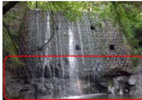
砂防堰堤の基礎洗掘
