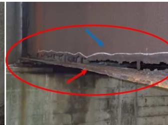
橋梁の桁のひび割れ、腐食
