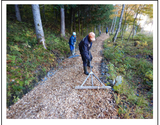
【木製チップ敷き均し作業状況】
